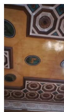
fenomeni di sfogliatura sulla patina pittorica a olio delle decorazioni della controsoffittatura piana
