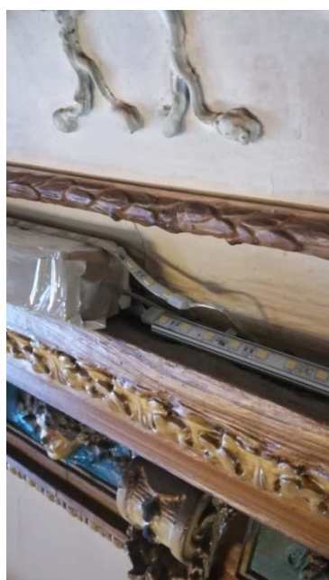
nastro Led e trasformatori sulla cornice
