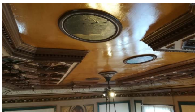
fenomeni di sfogliatura sulla patina pittorica a olio delle decorazioni della controsoffittatura piana
