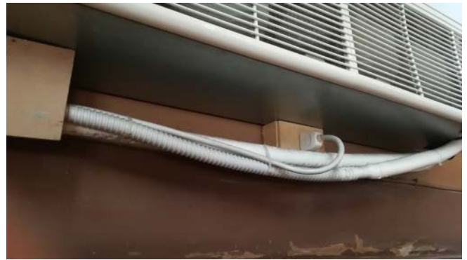
i cavi elettrici esterni e la posa di prese elettriche esterne e delle tubazioni del climatizzatore esterno all'inverter esterno
